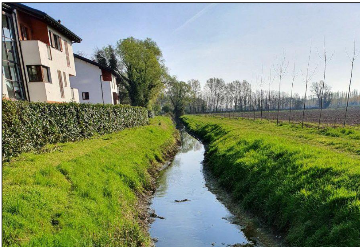
Roggia Grande – Valle scarico DP01804101
