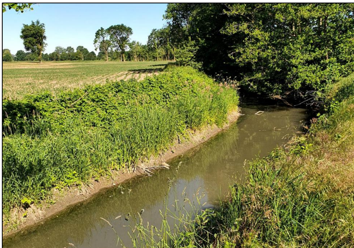
Colatore Nerone Gariga – Monte DP01807701
