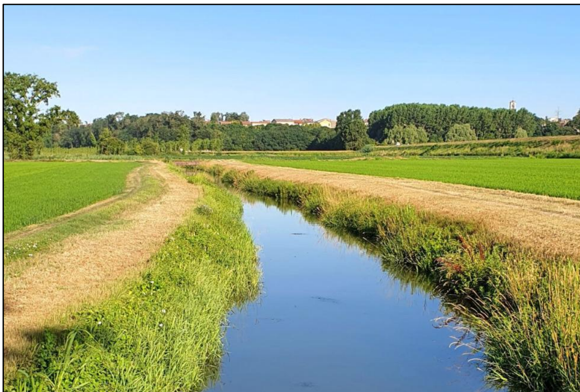
Roggiolo di Sommo – Valle scarico DP01815101
