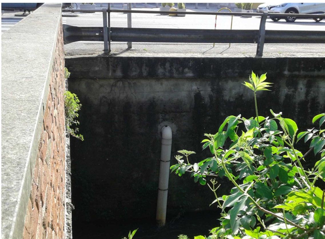
Foto 4: Certosa di Pavia – scarico non trattato nel Navigliaccio – zona della chiesa lungo ex SS35 – vista da Via Marconi
